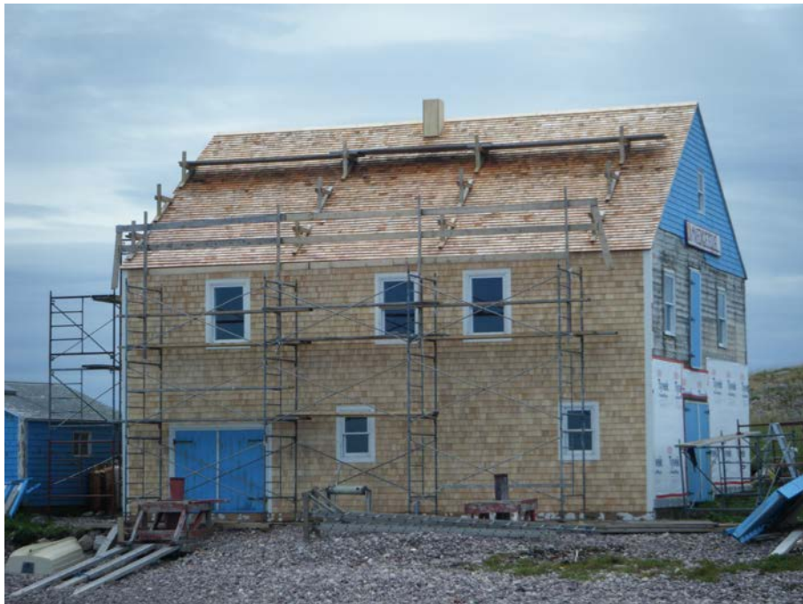
Restauration de la Maison Jézéquel (décembre 2013)
