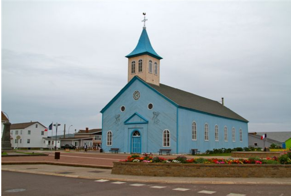
Église des Ardilliers, en partie restaurée
