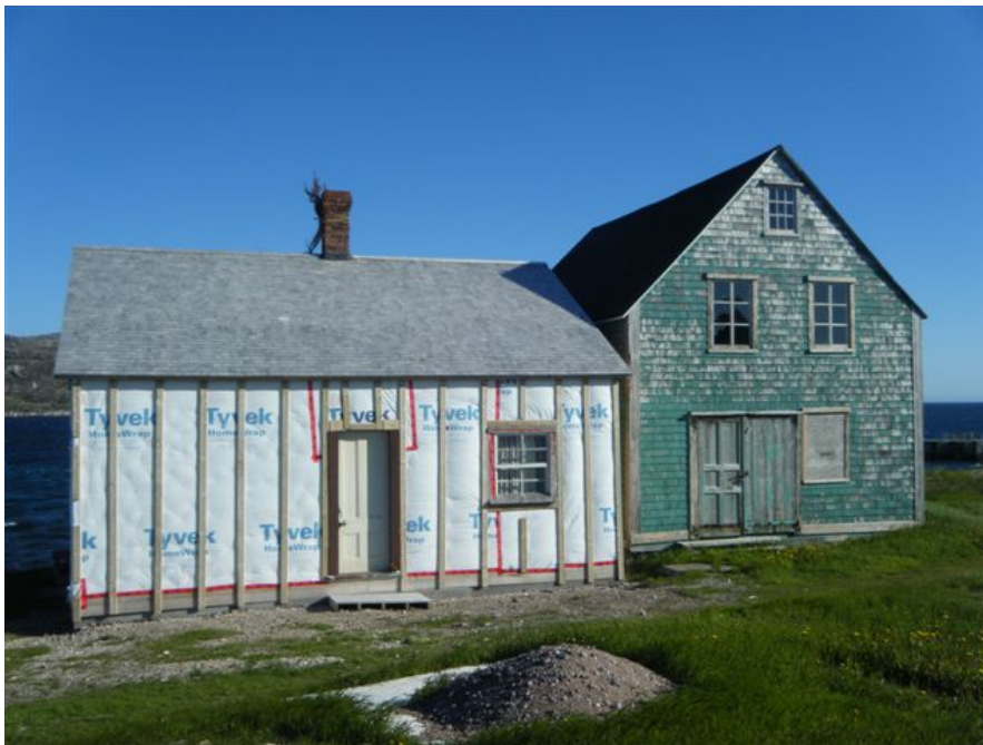
Ensemble Morel en cours de restauration (juin 2015)
