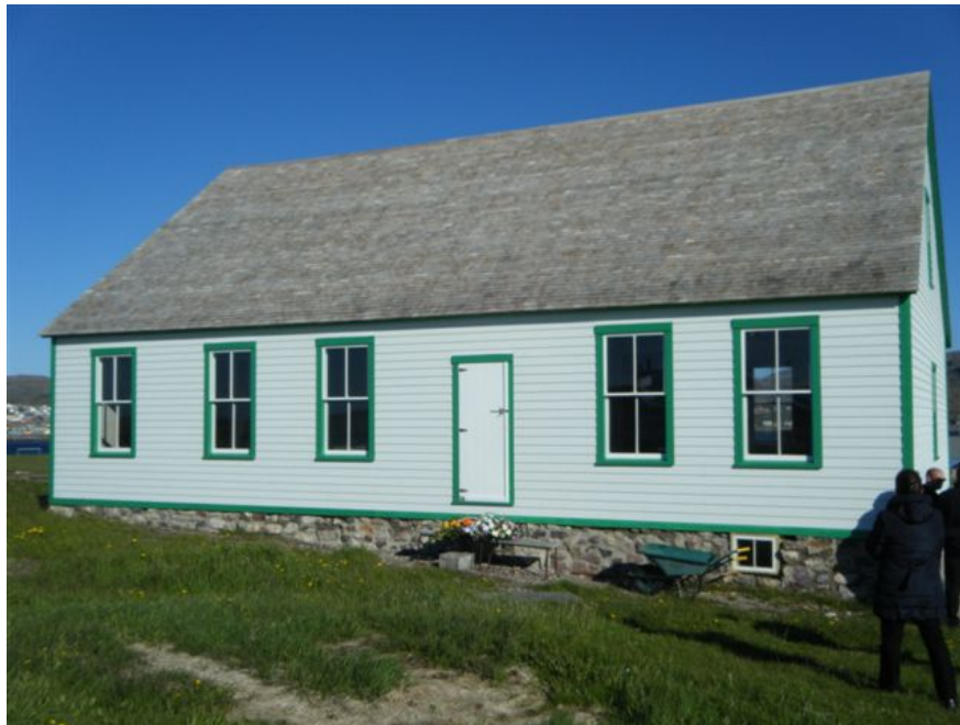
Ancien presbytère en cours de restauration, (juin 2015)
